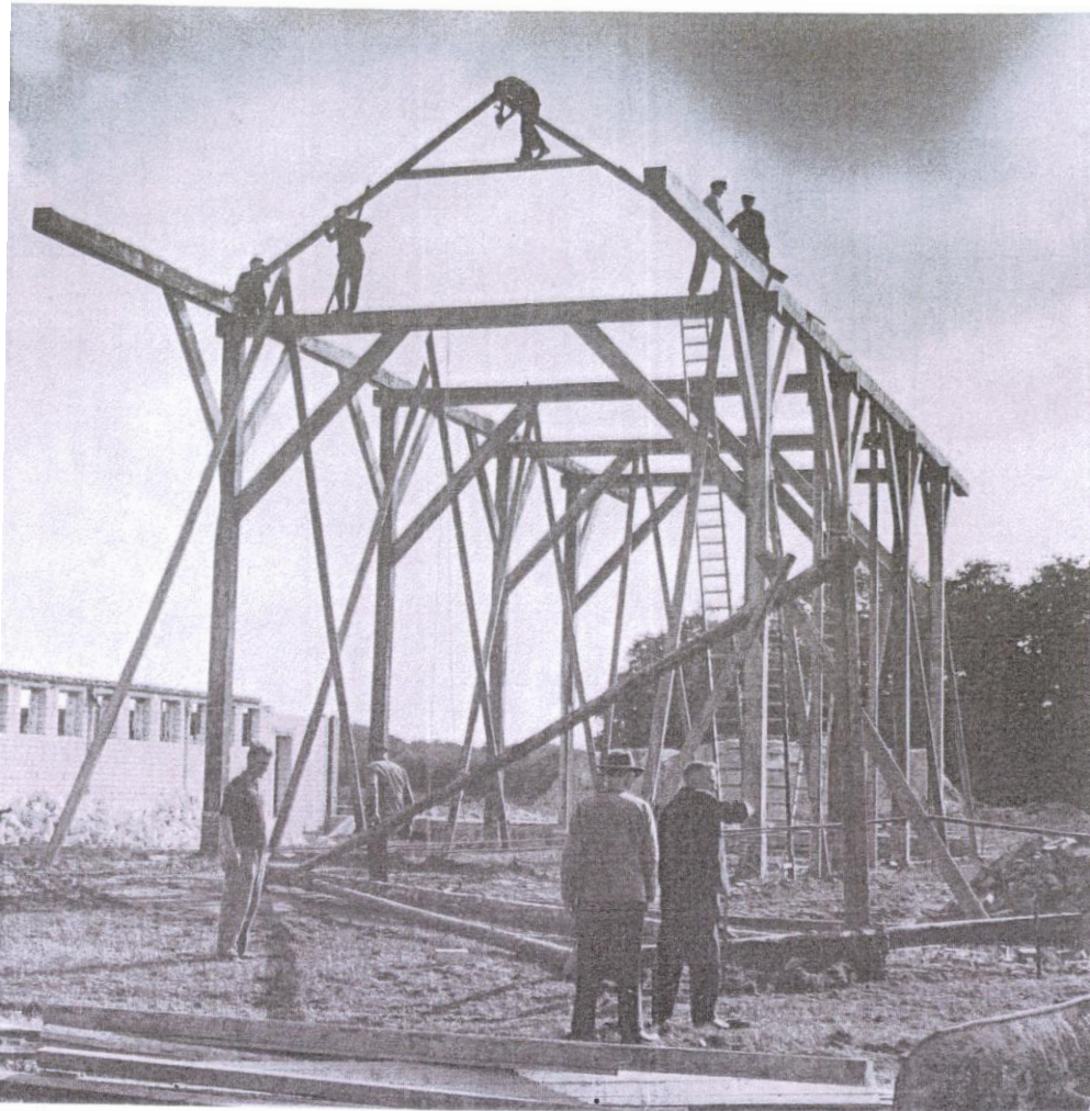
Abbildung 1: Zimmerleute errichten das Holzgerüst des Gulfhofes
